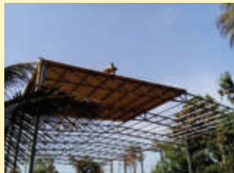
Copertura della palestra
