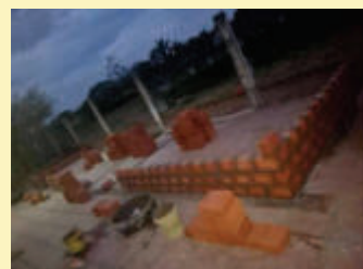
Prime basi della nuova costruzione
